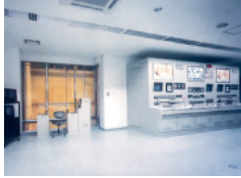
ゴミ・し尿処理施設維持管理
