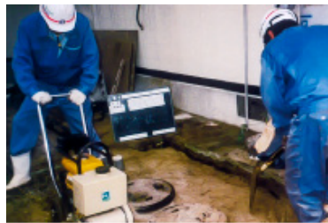
浄化槽の設計・施工および各種管工事
