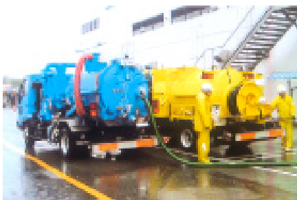
下水管の清掃(排水管洗浄)
