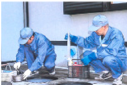
浄化槽の保守点検 維持管理
