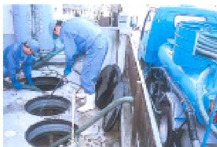
浄化槽の清掃
