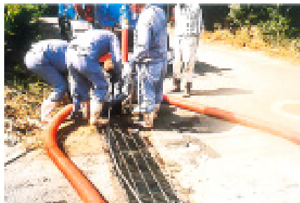
排水溝の清掃
